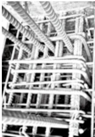
可耐震達7級的樑柱結構鋼筋
