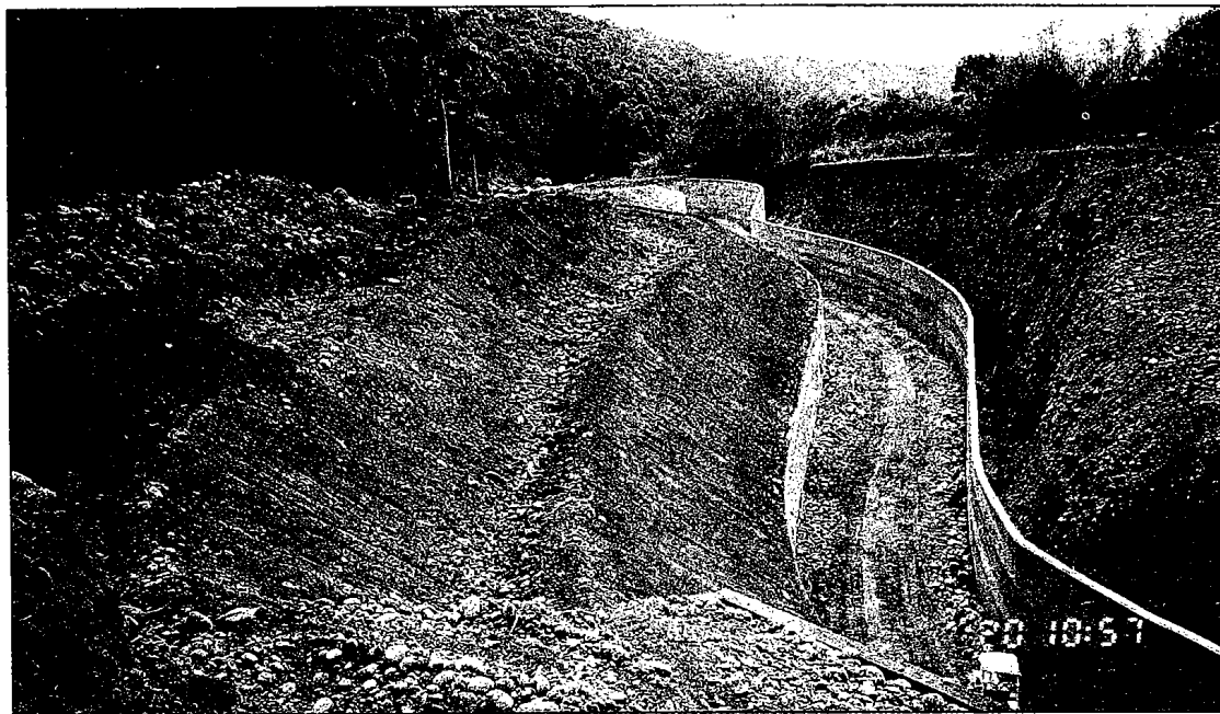
●從施工中的道場可看出基地地盤堅硬，屬良好承載層。
