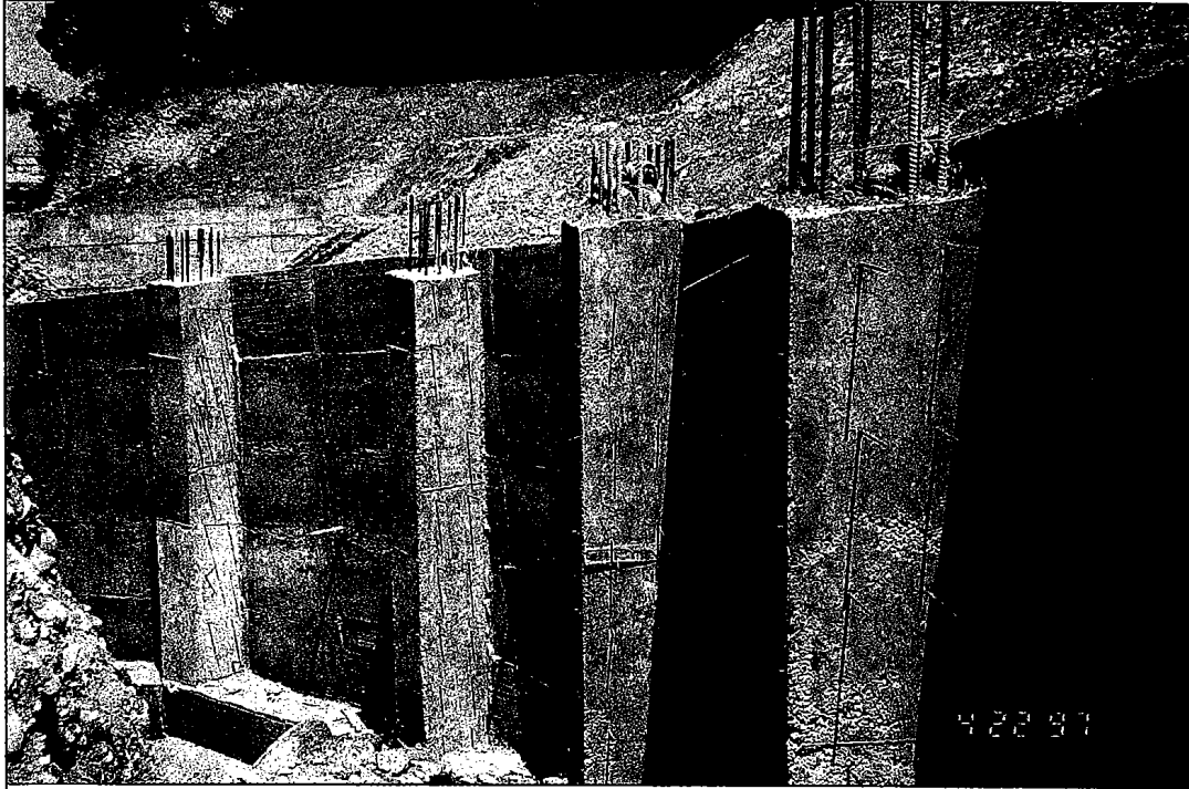
●為加強雙重防護，擋土牆外增加柱子廿三支，柱間並以地樑連接。
