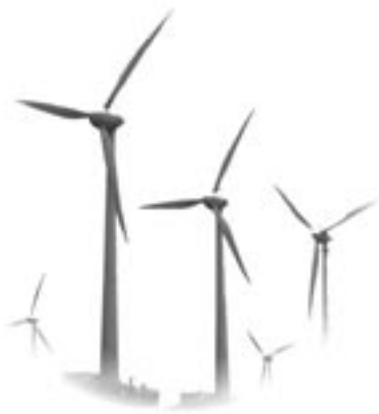
中屯的風力發電機組造型優美，已成為澎湖新地標。
