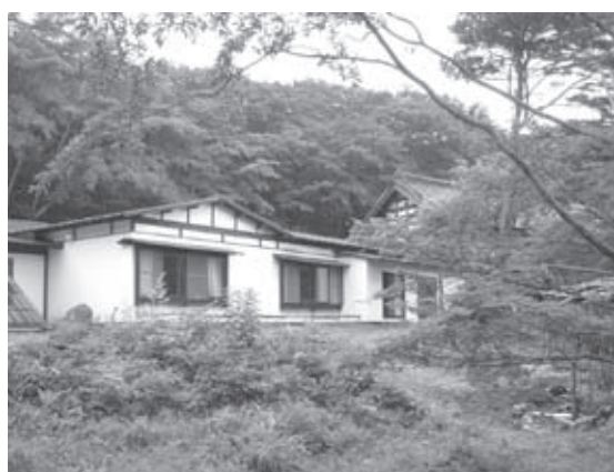
遠眺日本國主院・玉和殿主建築。
