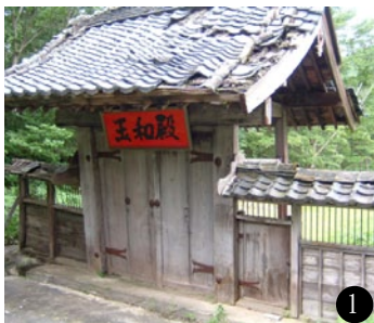
圖1/早期那須道場「玉和殿」大門。
