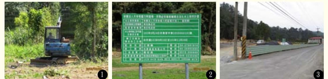
圖1/水土保持工程施工前，進行南大門工地整地作業。
