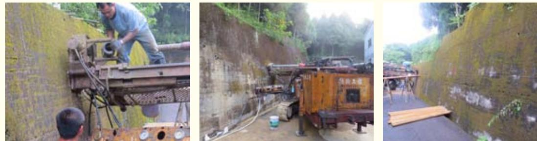
天裕營造於山坡擋土牆上施作安裝毛細式透排水管工程。
