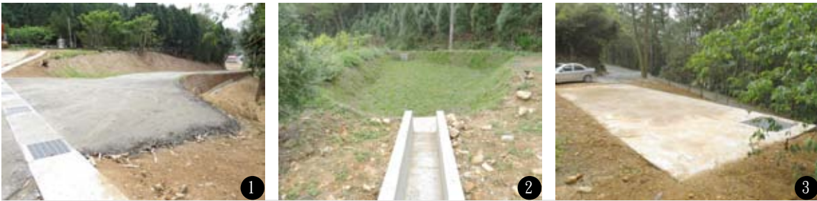
圖1/通往南大門的聯外道路與路旁水溝。
