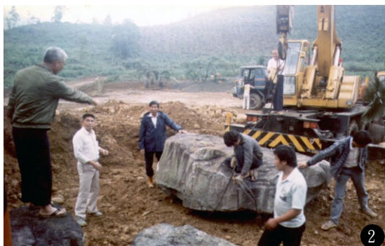
圖2/鐳力石吊裝現場。
