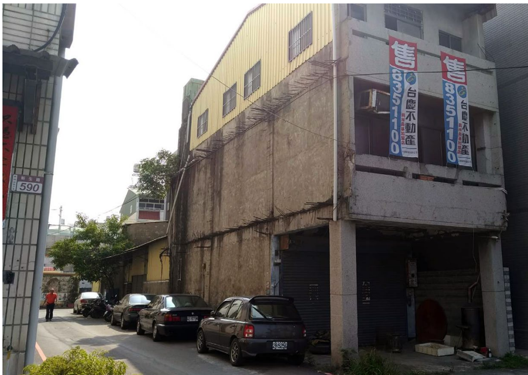
尚未整修的未來天祥堂。
