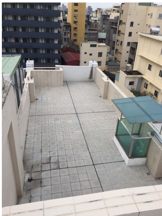
即將整修並加蓋的頂樓樣貌。
