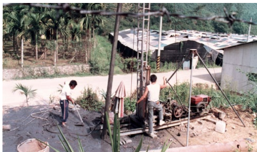
民國77年6月在鐺力阿道場前院旁鑿「金雷泉」的施工情形。
