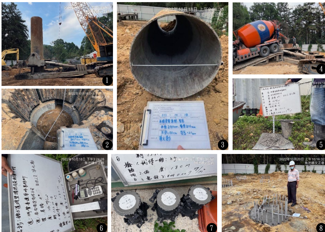
圖1/基樁套管吊放。 圖2/基樁中心位置檢查。 圖3/基樁套管查驗。 圖4/基樁混凝土澆置。 圖5/基樁混凝土坍度試驗。 圖6/基樁混凝土氯離子檢測。 圖7/基樁混凝土抗壓試體製作。 圖8/張緒疏主委驗收6支基樁。
