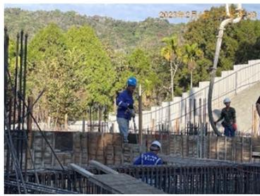
混凝土澆置時需依規定頻率使用震動棒搗實混凝土，避免產生蜂窩現象。
