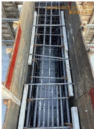
混凝土澆置前確認模板內乾淨無雜物。
