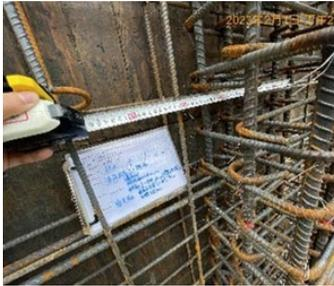
1F牆鋼筋入柱深度查驗。
