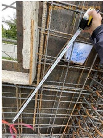
1F牆開口補強斜筋查驗。
