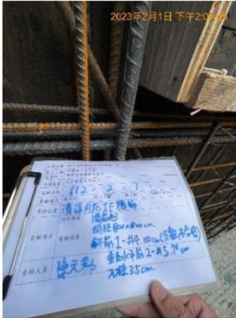
1F牆開口補強鋼筋號數查驗。
