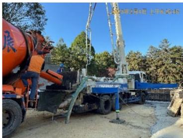
嚴格監督混凝土不可加水，避免降低混凝土強度。
