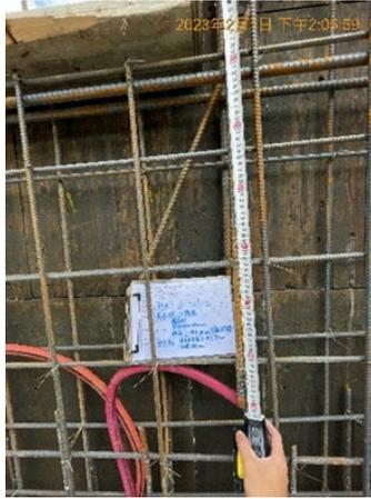
1F牆開口垂直補強鋼筋延伸長度查驗。
