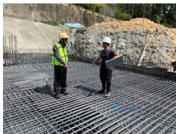
何肇喜建築師(左)督導工地鋼筋綁紮與承包商品管工程師檢討(右)(拍攝日期：112年3月8日)。
