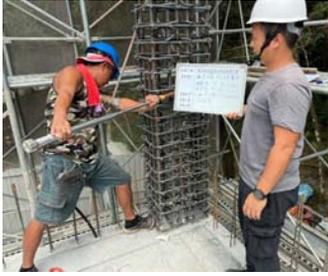
營造單位自主檢查鋼筋續接器扭力試驗(拍攝日期:112年4月15日)
