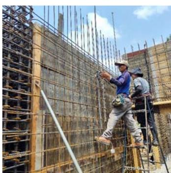
勘察鐮力道院BF排煙風管穿越牆壁未預留開口-要求配管修改及模板補課開口預留(拍攝日期：112年4月12日)
