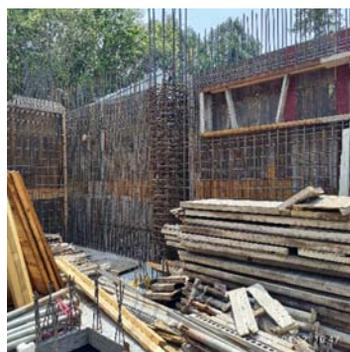
勘察鐮力道院BF發電機機房進排氣通風百葉窗未開口-要求牆筋修改. 模板補設置開口預留(拍攝日期：112年4月12日)
