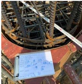
查驗鋼筋柱保護層是否符合規定,避免日後鋼筋裸露(拍攝日期:112年4月23日)
