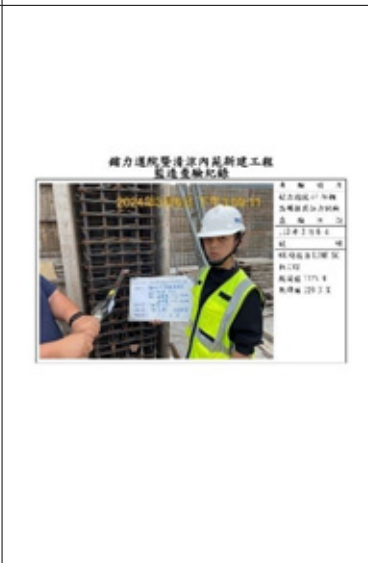
鑼力道院4F續接器扭力試驗檢驗停留點查驗(拍攝日期:113年3月6日)
