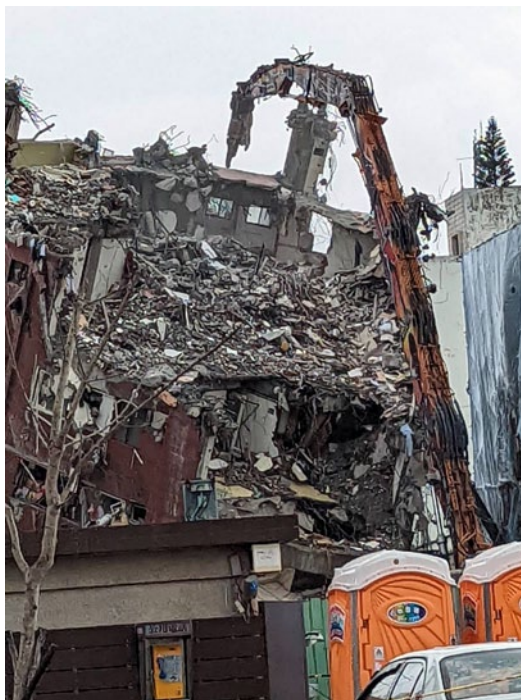
▲天王星大樓拆除的景象。
