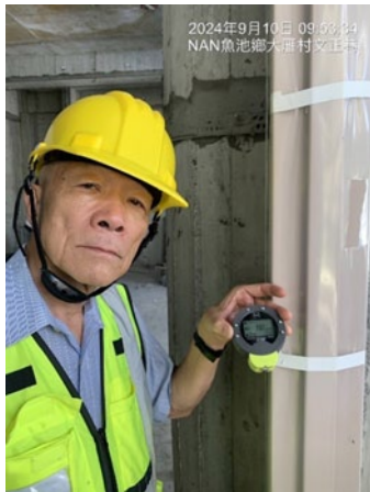
監造建築師督導工程紀錄 (紀錄日期：113年9月10日)
