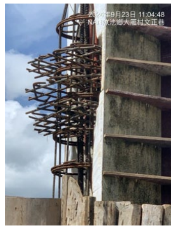
監造建築師督導工程紀錄 (紀錄日期：113年9月23日)
