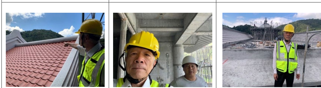
監造建築師督導工程紀錄(紀錄日期: 113年10月11日) 監造建築師督導工程紀錄(紀錄日期: 113年10月22日) 監造建築師督導工程紀錄(紀錄日期: 113年11月27日)
