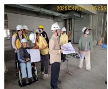
樞機使者團工程現地參訪情形(拍攝日期：114年4月7日)
