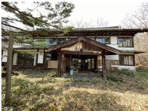
▲野武士館尚待同奮出心、出力、出力修葺整建。
